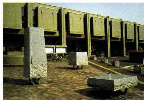
唯一のパブリックアートといえる関根信夫作の「歩の石」。周辺も含めメンテナンスがなされていない。
