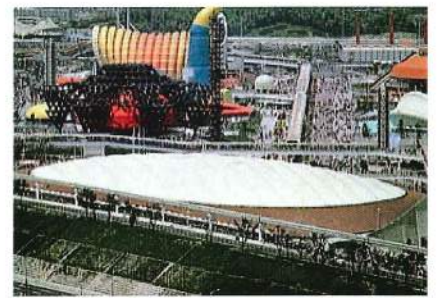
アメリカ館—このときの巨大空気膜構造の原理が、東京ドームに活用されている。左奥に見えるのが、同じく太陽工業が手がけた富士グループパビリオン
