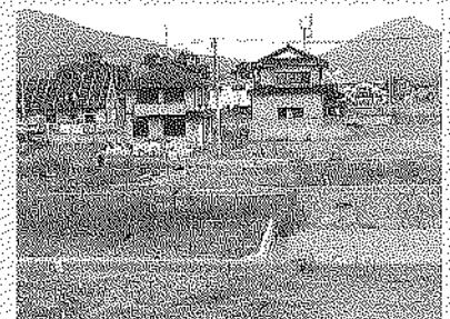
スーパー堤防から見た渡波長浜地区
