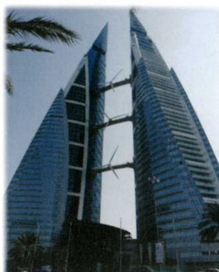
図9 ビルドイン風車
