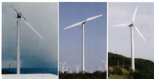
図6 1～3枚の羽根枚数による外観の相違
