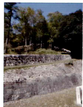
閑谷学校 野石積の土留
