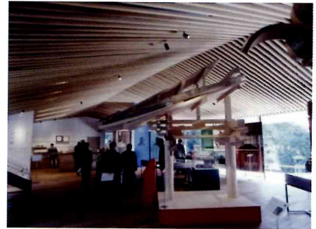
竹中道具館 ロビーの船底天井
