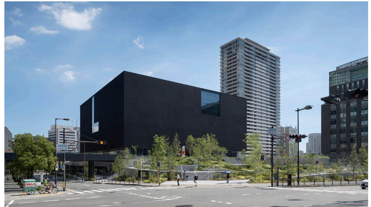
北東交差点より、つづら折りのアプローチにより2階へとつながる。
