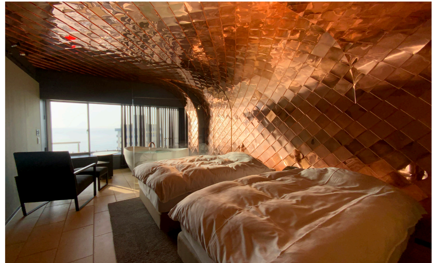
壁・天井が一体となった銅板菱葺きが日本海の景色を細かく分節化し、室内に映し出す
