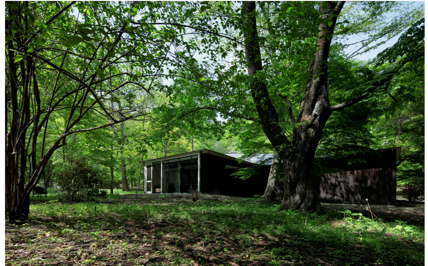
樹木の隙間に3方向に広がるヴォリュームをおき、梁の勾配変化による曲面屋根を架けた
