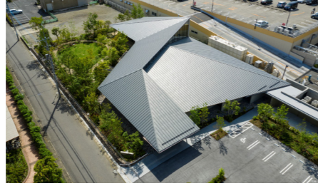
「新柏クリニック糖尿病みらい」 作者:(株)竹中工務店 齋藤華織 菅原努 所在地:千葉県柏市新柏
