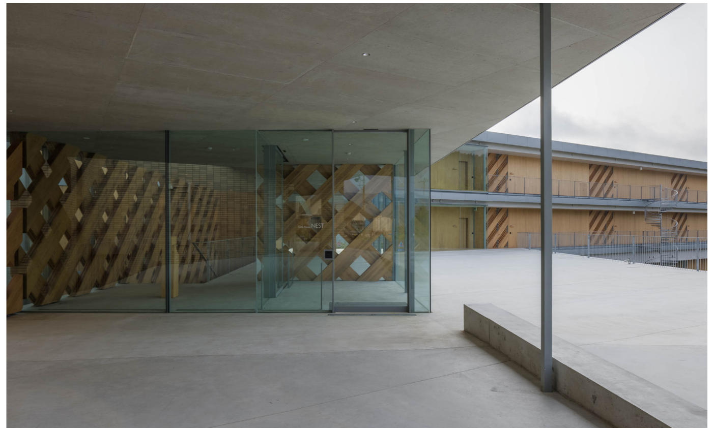
既存棟と新築棟をつなぐ「ホール/テラス」。庇付きのイベントスペースでもある 写真撮影：鈴木研一
