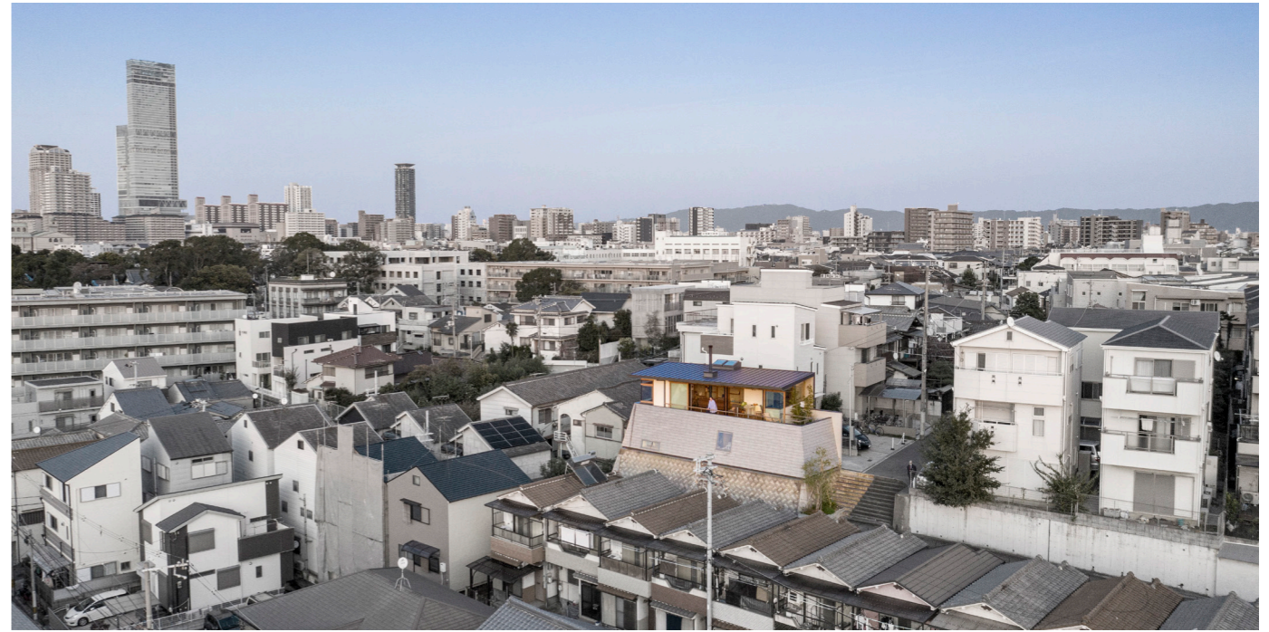
急峻な敷地を補強して上町台地の形をそのまま持ち上げたボリューム。敷地の短所を長所に反転し、都市にありながら自然の変化を感じる住まい
