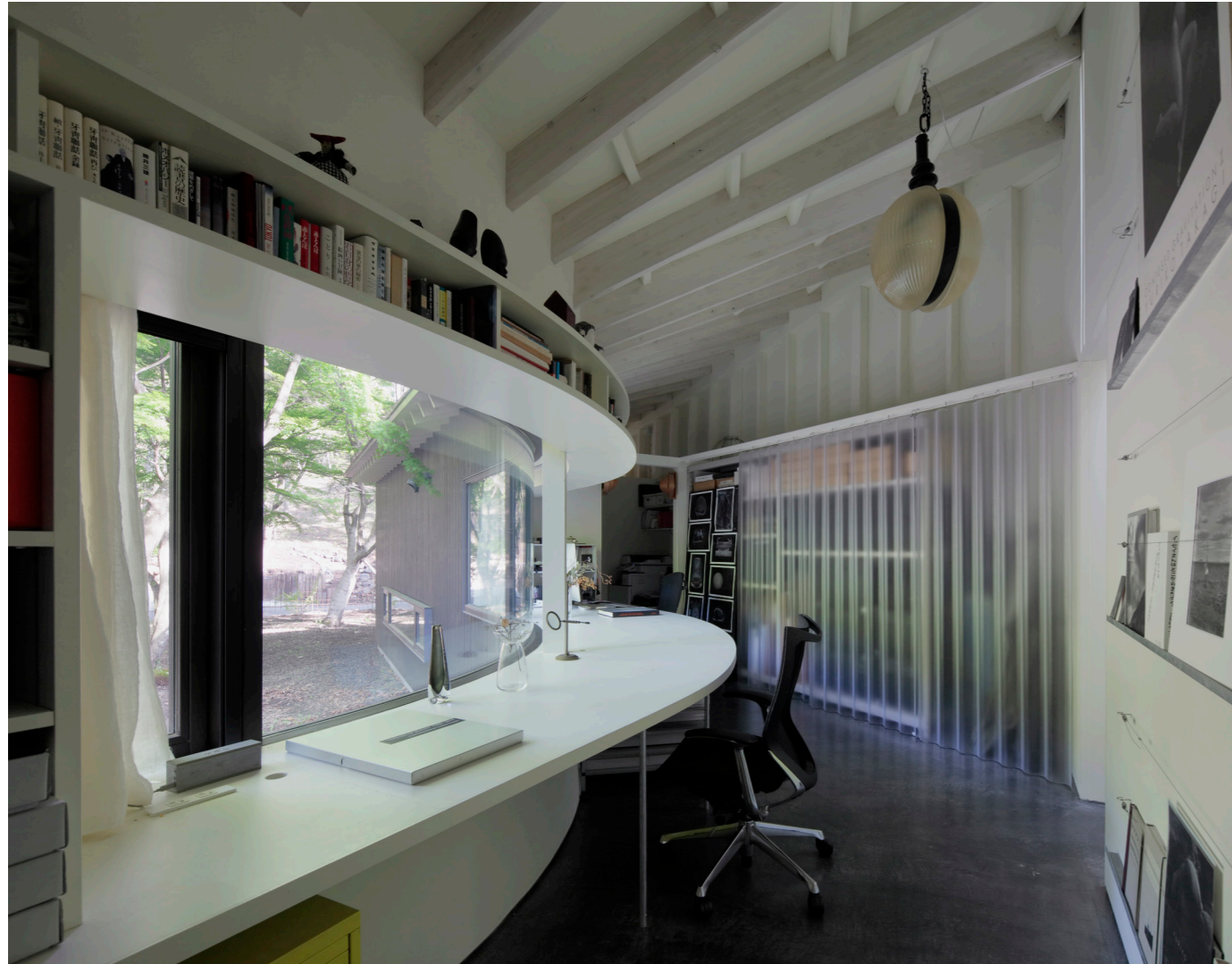
Rの外壁に沿ったデスクと柱や間柱あわらしの背骨壁にはさまれたオフィス
