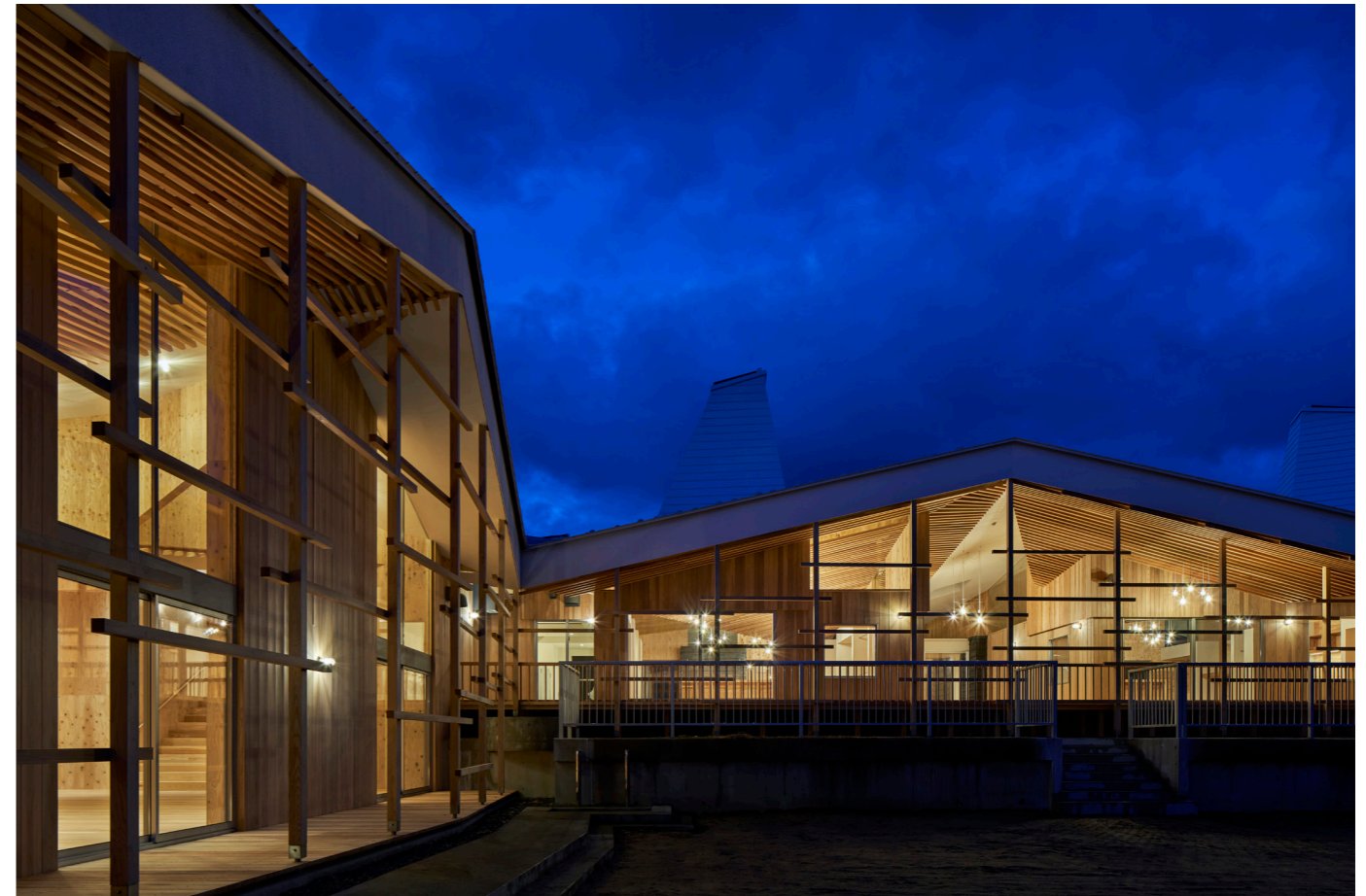
ムッレの森(敷地南側)より、村の特徴が反映された園舎外観を見る
