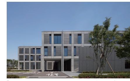
「西部石油(株)山口製油所新事務所棟」 作者:AA建築設計工房 川北英 大成建設(株)一級建築士事務所 横手真一郎 関明子 遠藤僚 岩崎利幸 尾毛谷阿弓 (株)コンパッソ 菊竹雪 所在地:山口県山陽小野田市西沖
