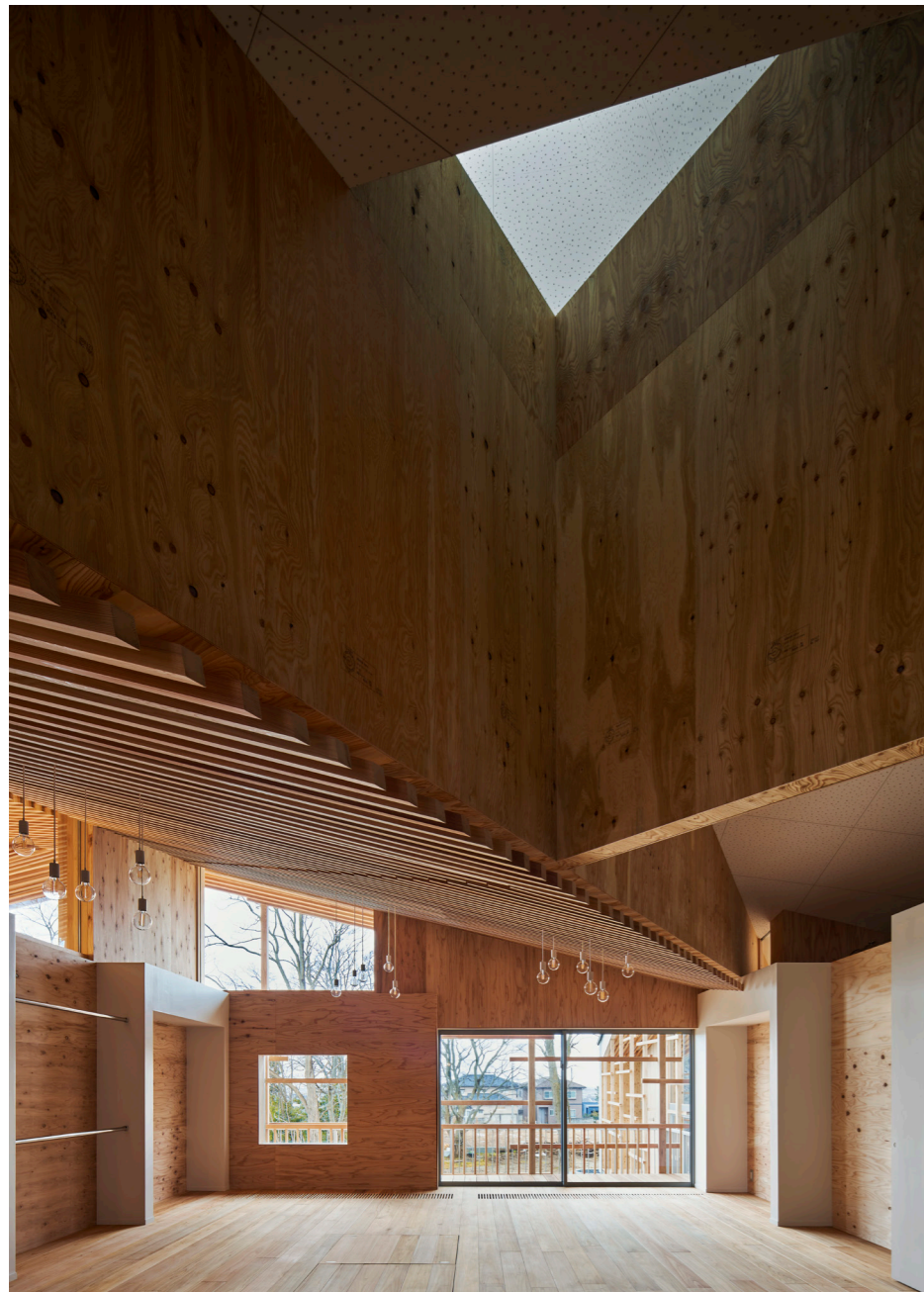
5歳児室を見る。トラス交点と間仕切り壁の位置がずれ、隣室同士の空気や気配がつながる 写真撮影：藤井浩司 TOREAL
