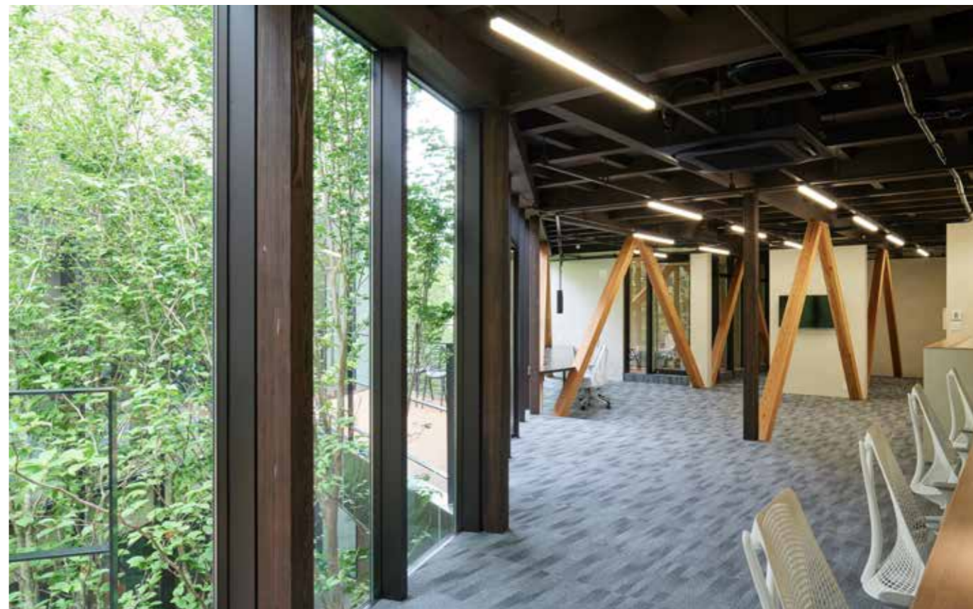
5mキャンティレバーを実現する木造架構と緑のカーテン
