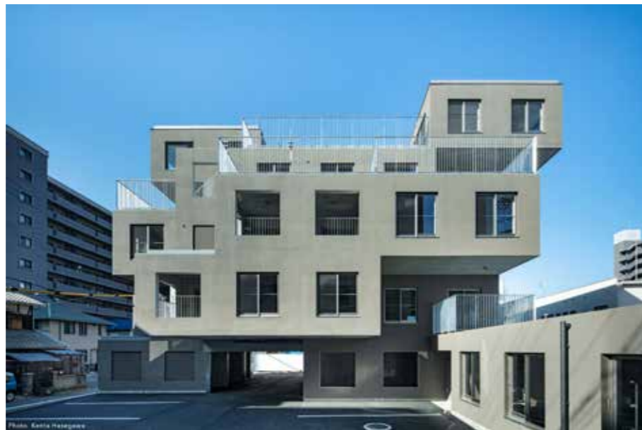
写真撮影:Photo Kenta Hasegawa
