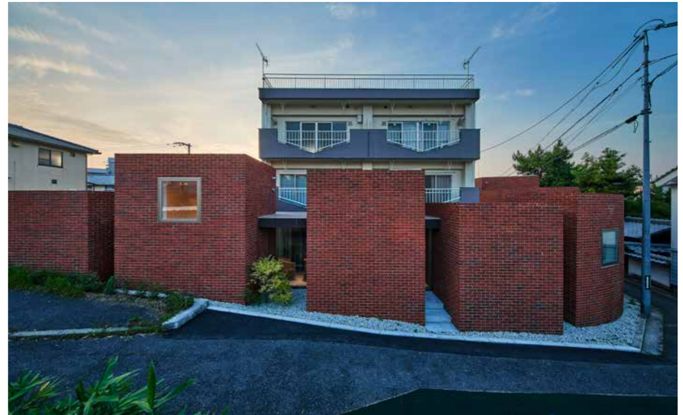
部屋毎に分節した建物を施主の祖母が住むアパートを包むように置くことで街と多孔質に繋がる境界になる
