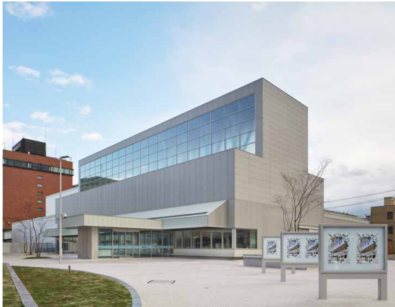
外観:周囲への圧迫感と日影をおさえる凸型ボリュームとキールトラスによるハイサイドライト
