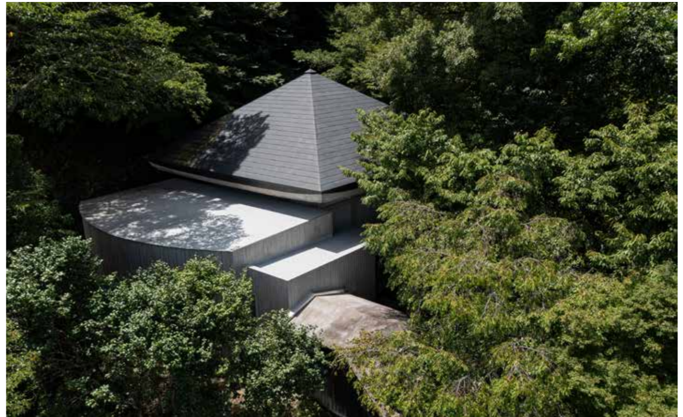
既存収蔵庫の屋根は、瓦葺から経年変化の美しいチタン亜鉛合金葺きに改修
