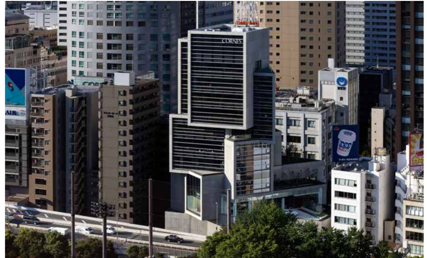
北側外観：周辺環境の魅力を場所ごとに取り込めるように立体的に積層したボリューム
