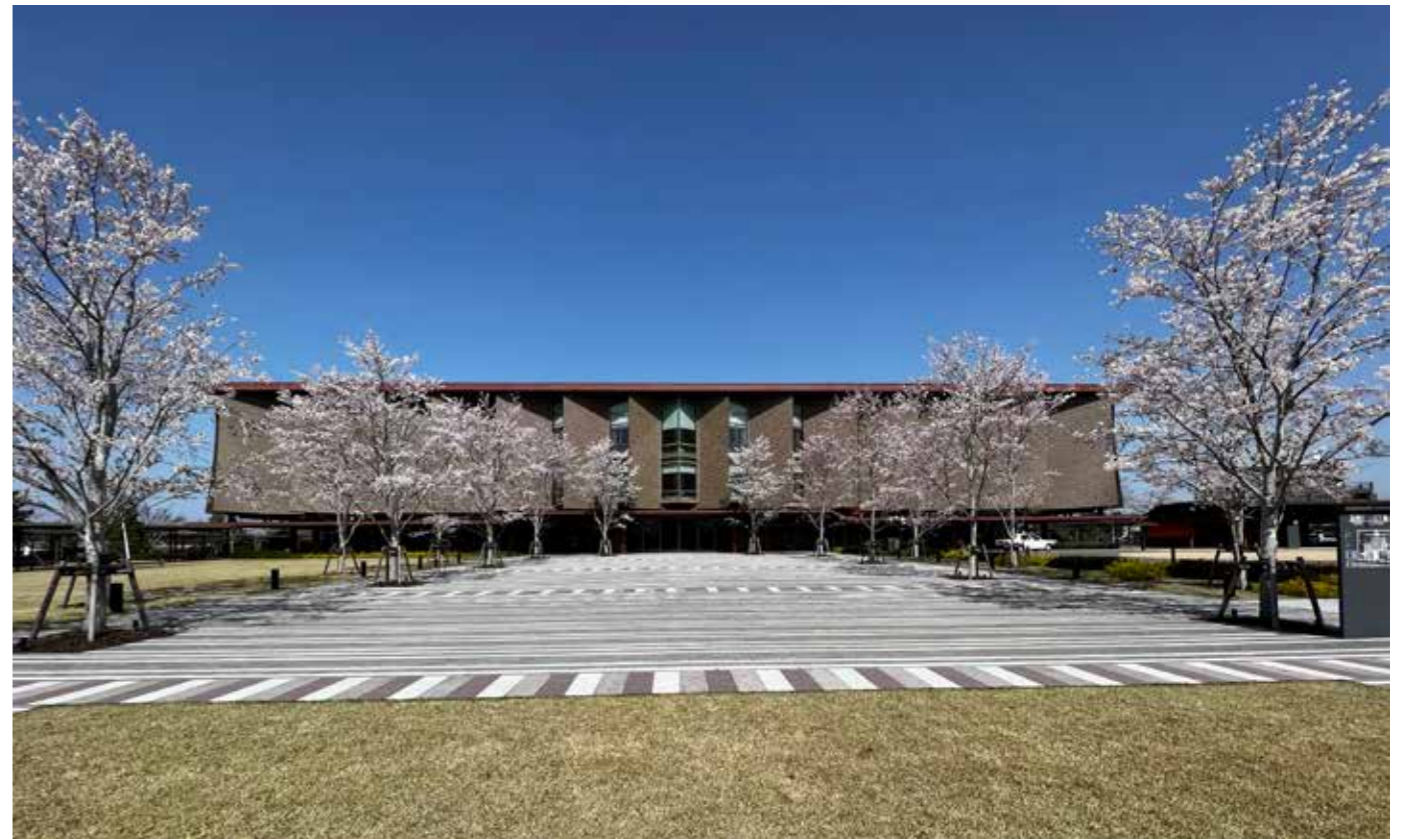
南東外観。本を“めくる”から着想された、カーテンウォールとタイル張りのPCパネルが雁行
