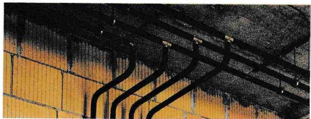
メプラインは、金属と樹脂の特長を最大限に生かし、軽量で可撓性のある給水・給湯用配管です。
