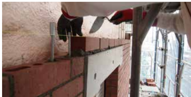
建築構造物を断熱材で包み込み(外断熱工法)、外装としてレンガを組積中
