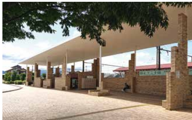
上州富岡駅(群馬県富岡市) 高さ5mの自立レンガ壁。プレストレス工法
