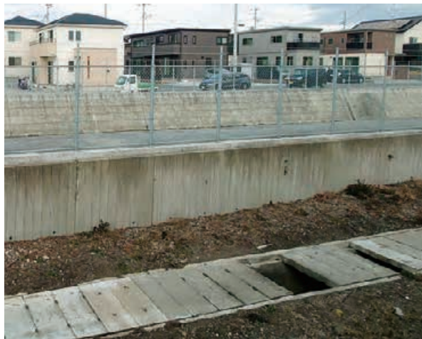
フェンスで囲まれた一般的調整池
