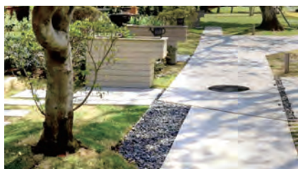
リソルの森(設計:三谷徹)。木漏れ日を映し、根上がりにも備える園路のデザイン
